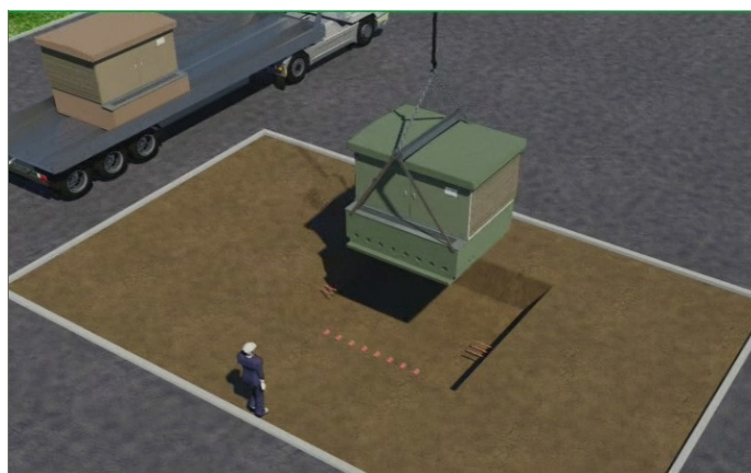
(الف): آماده کردن محل پست طبق مشخصات فنی
