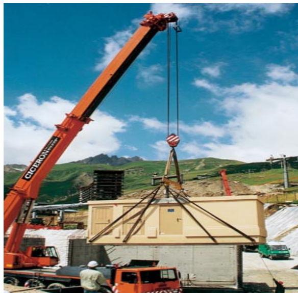
شکل (۱۶): طریقه جابجایی مناسب پست پیش‌ساخته کمپکت با استفاده از تسمه غیرفلزی و تیر حمل
