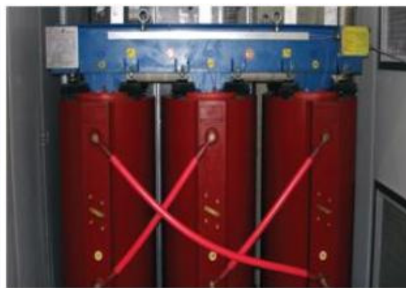
(الف): ترانسفورماتور توزیع خشک
