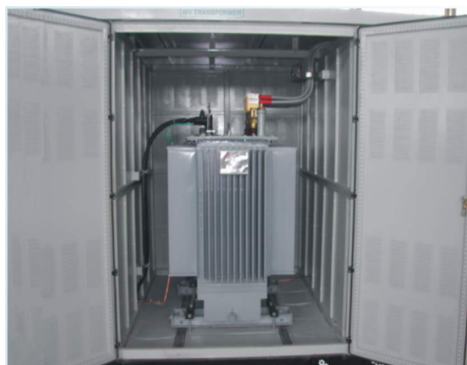
(ب): ترانسفورماتور توزیع روغنی هرمیتیک
