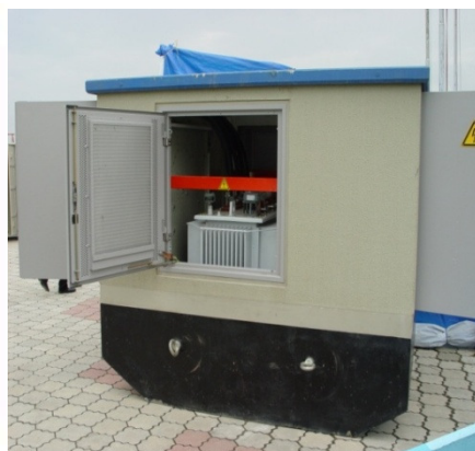
شکل (۱۲): پست پیش‌ساخته کمپکت بدون نیاز به احداث فونداسیون در محل
