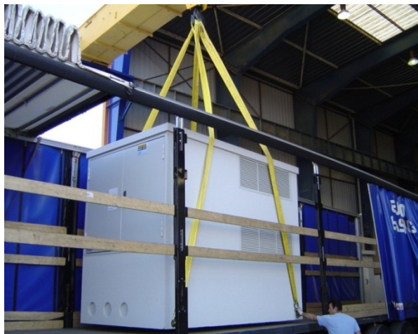
شکل (۱۵): طریقه جابجایی مناسب پست پیش‌ساخته کمپکت با استفاده از تسمه غیرفلزی
