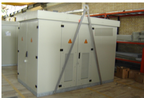
شکل (۱۷): استفاده از قالب فلزی جهت جابجایی پست پیش‌ساخته کمپکت
