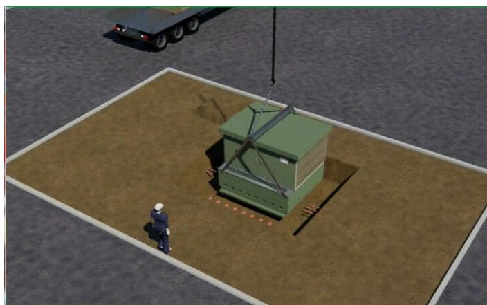
(ب): قرار دادن پست روی نشیمن‌گاه
